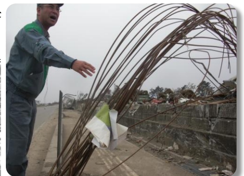
● 津波でコンクリート部分が破壊された電柱。鉄筋だけが残る。宮城県名取市 閑上地区
